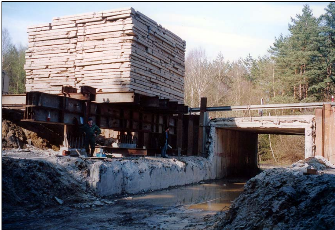
Rys. 2. Stanowisko do badania statycznego nośności pła wierconego \phi 1200 mm, Obwodnica Trójmiasta, wiadukt 4A
