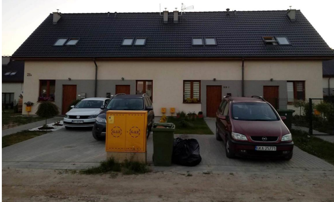
Rys. 3.1. Budynki poddane badaniom drgań komunikacyjnych.
