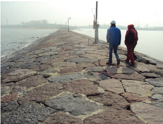
Rys. 4. Widok na konstrukcję wykładziny falochronu z XIX wieku
