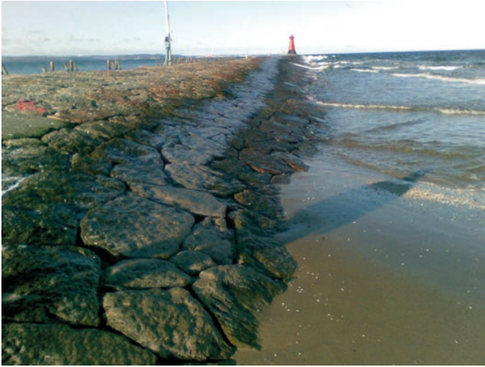
Rys. 3. Kamienna wykładzina falochronu przed przebudową
