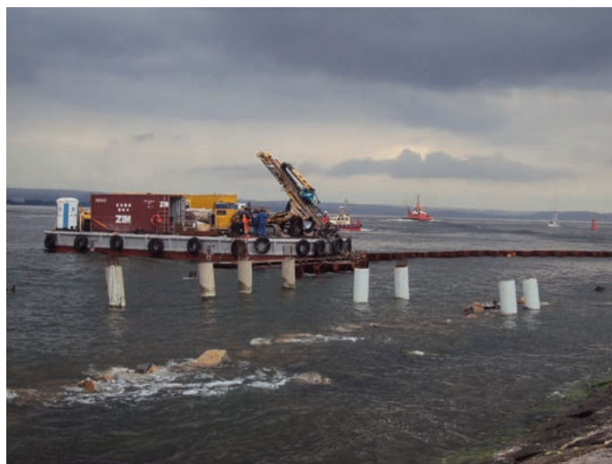
Rys. 11. Wykonywanie mikropali w części głowicowej
