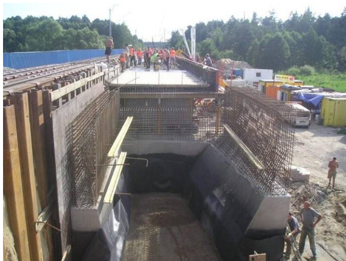
Rys. 7. Widok przyczółka od strony zasypu. Po lewej stronie widoczne dodatkowe skrzydło pionowe w osi przyczółka
