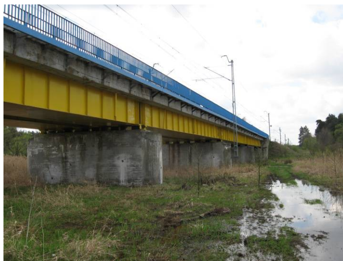
Rys 2. Widok ogólny mostu przed przebudową
