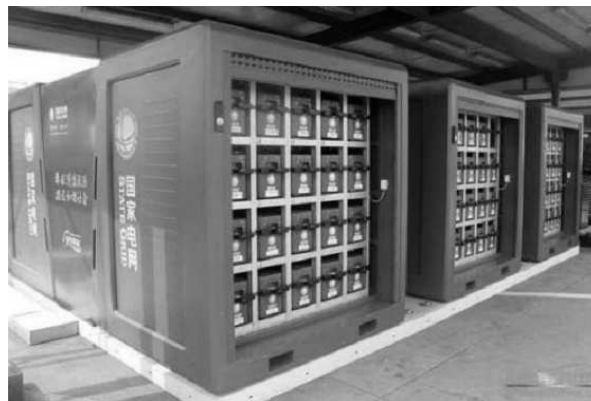
Rys. 2. Demonstracyjna stacja wymiany baterii akumulatorów firmy HEPSTD w Chinach [18]
