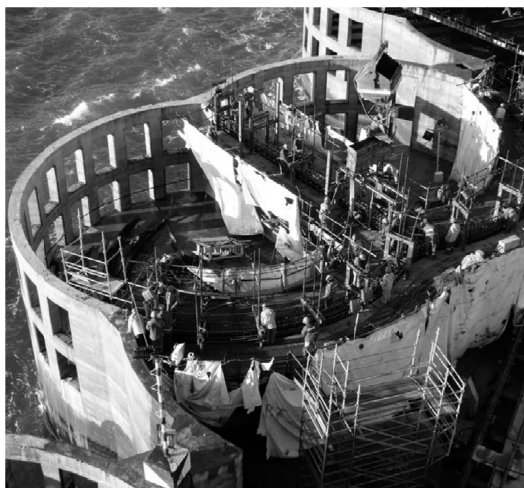
Rys. 8. Widok ażurowych ścian budowanych ponad poziomem spokoju, Tanger (Maroko)
