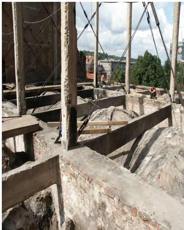
Rys. 4. Widok sklepień szkieletu żelbetowego nawy środkowej.
