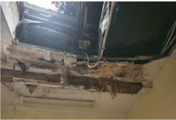
Photo. 5: Zapadnięty dach w części nad dawnymi pomieszczeniami biurowymi (A) Collapsed roof in part above former office spaces (A)
