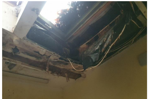
Photo. 5: Zapadnięty dach w części nad dawnymi pomieszczeniami biurowymi (A) Collapsed roof in part above former office spaces (A)
