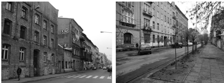
Fot. 1. i 2. Ulice Łodzi w rejonie projektów rewitalizacyjnych
