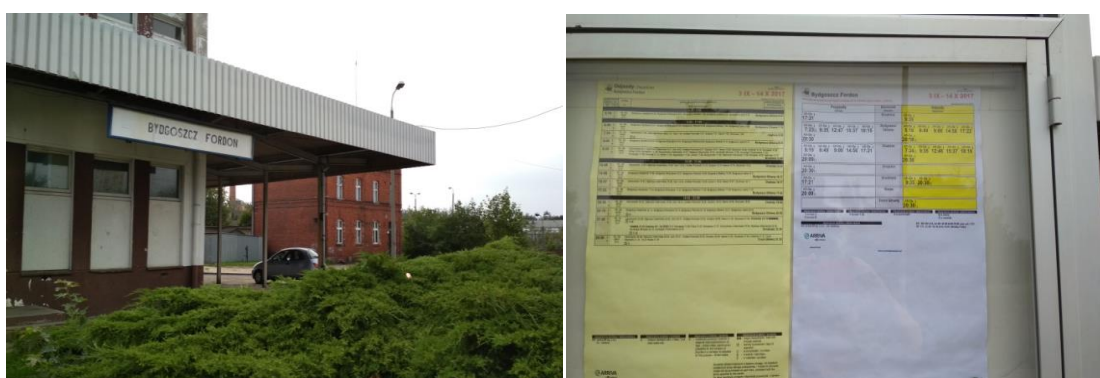
Fot. III. 37. Obecna stacja kolejowa w Fordonie. Budynki nieczynne, poczekalnia zamknięta mimo istniejących połączeń, fot. autorka.
