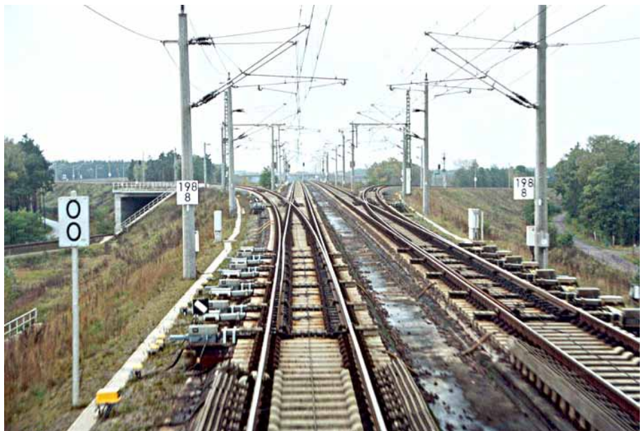
6. Odgańlenie toru na linii wielkiej prędkości wykonane za pomocą rozjazdu 4800/2450 1:24,26 [10]
