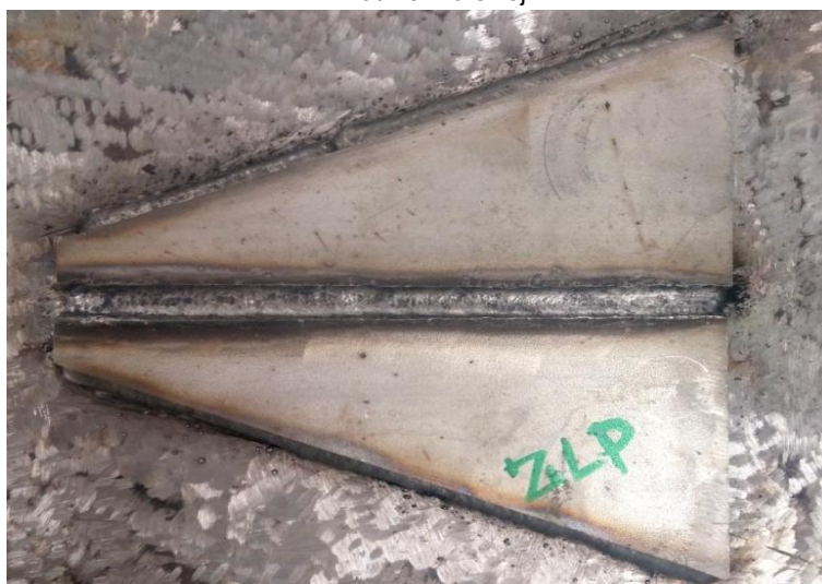
Rys. 120. Widok spoiny próbnej w próbce o zmieniającej się sztywności 1 ZLP wykonanej w na powietrzu
