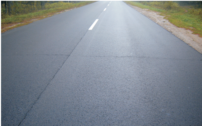
Rys.1. Spękania poprzeczne wywołane oddziaływaniem niskich temperatur Fig.1. Transverse cracking due to low temperature action
