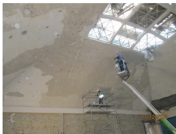
Rys. 12. Naprawa ubytków betonu wewnętrznej powierzchni powłoki kopuły, widok od strony zachodniej (zdjęcia autorów – 17.12.2013)
