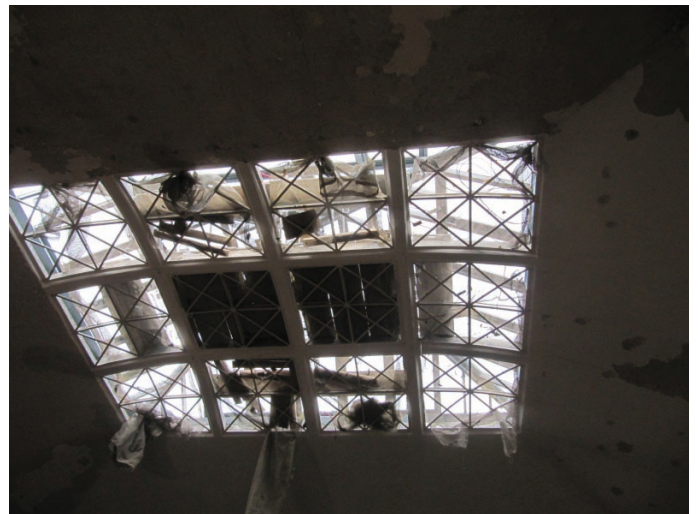
Rys. 21. Ruszt żelbetowy świetlika w widoku z wnętrza hallu Dworca Morskiego.
