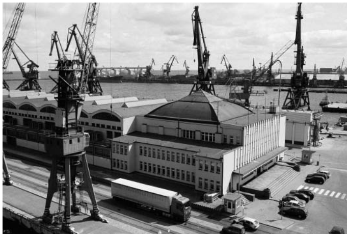
Rys. 2. Widok Dworca Morskiego w Gdyni od strony północnej (Nabrzeża Francuskiego), (2011 r.). (Źródło fot.: http://stefanbatoryoceanliner.weebly.com/gdynia-port.html )
