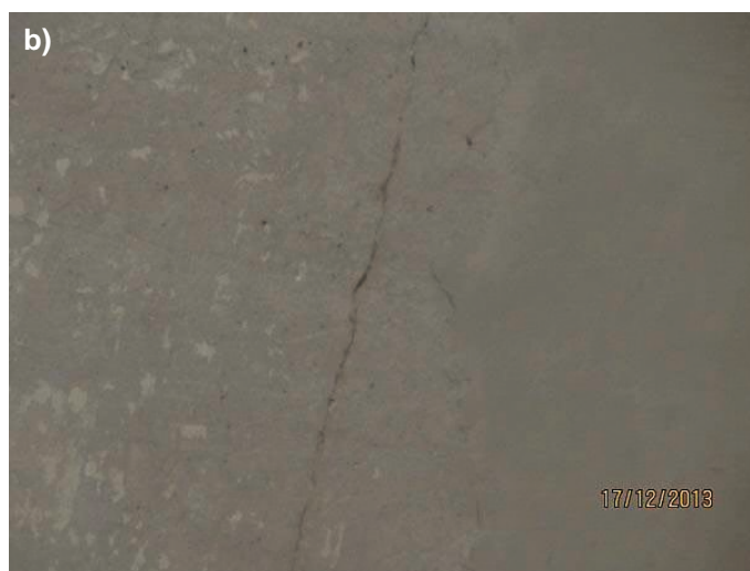
Rys. 11. Zarysowanie powłoki od strony Nabrzeża Holenderskiego a) widok zarysowania powłoki od strony południowej, b) szczegół rysy (zdjęcia autorów – 17.12.2013)
