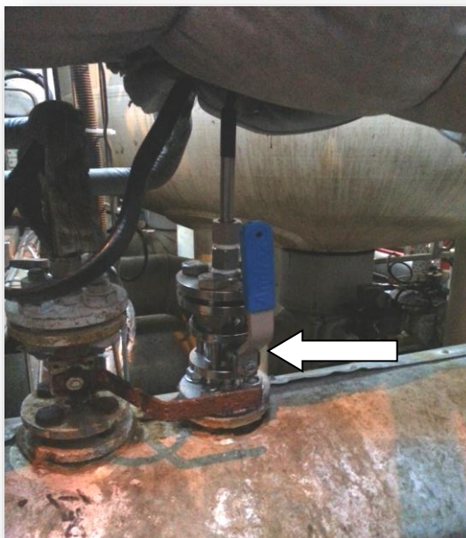
Rysunek 47. Miejsca montażu czujników LPR.
