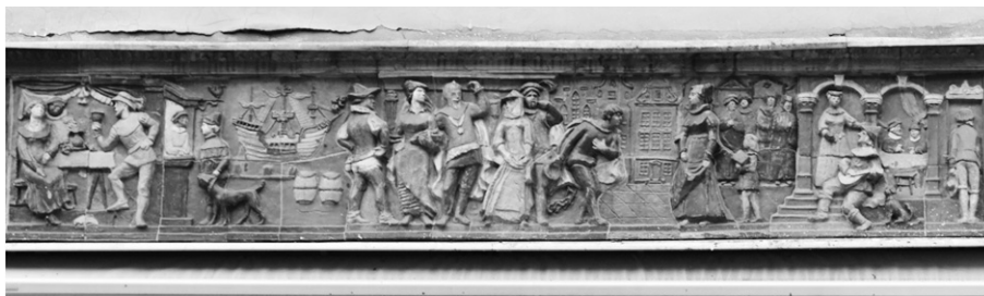
Fot. 6. Fragment elewacji z ceramiki szkliwionej autorstwa E. Roguszcza i St. Mizerskiego. Długa 61 Fot. [J. Tkaczuk].
