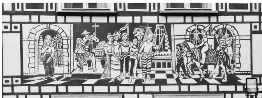
Fot. 5. Detal fasady kamienicy przy Długim Targu 26. Sgraffito.
