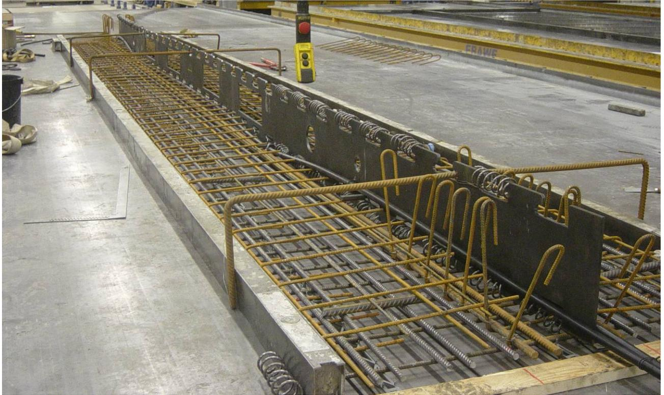
Bild 9: Eingebautes Stegblech mit Wendelbewehrung, Öffnungen und Spannkabel
