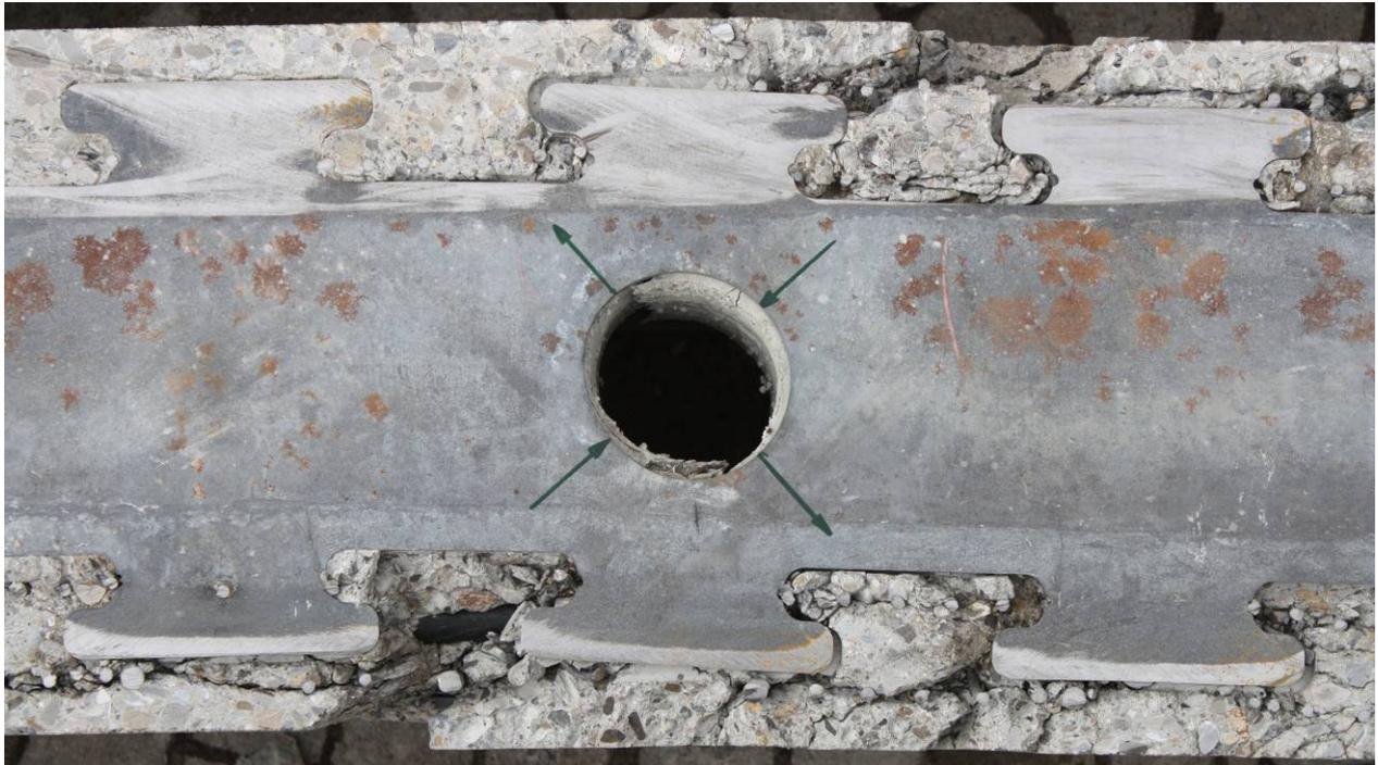
Bild 22: Schnitt an einer runden Stegöffnung und ovale Verformung
