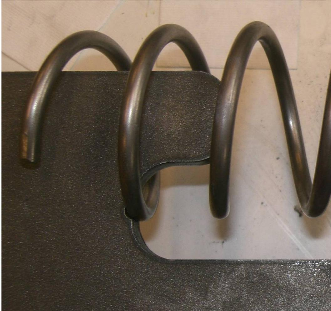
Bild 7: Fixierung der Wendelbewehrung an der Puzzleleiste
