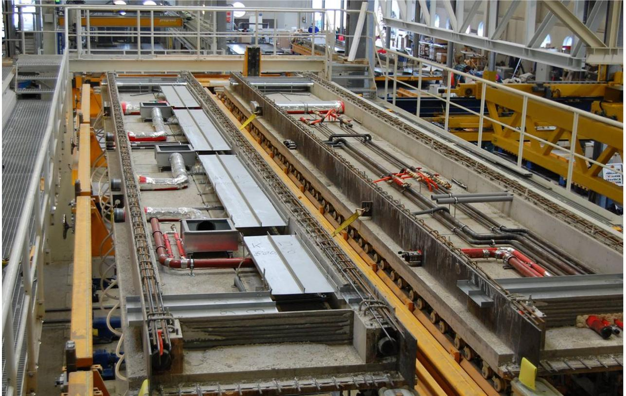
Bild 2: Im Hohlraum der Sandwichdecke verlegte Installationsleitungen
