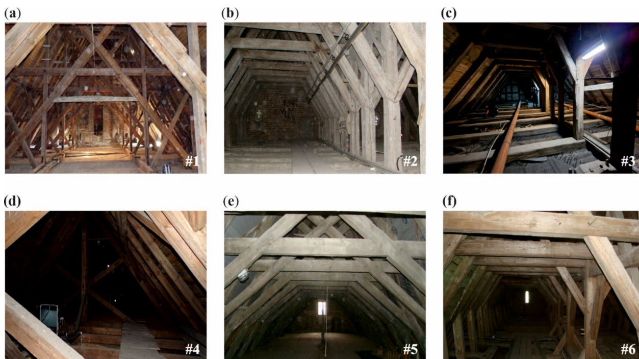
Fig. 5 Roof trusses in: a Miłobądz (#1), b Pruszcz Gdański I (#2), c Kieźmark (#3), d Pruszcz Gdański II (#4), e Koźliny (#5), f Trutnowy (#6)
