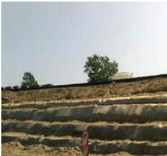
1. Wielowarstwowe ułożenie geosyntetyków w nasypie
