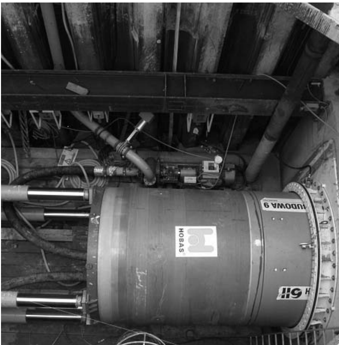
Rys. 4. Wprowadzanie kolejnej rury (materiały firmy HOBAS)
