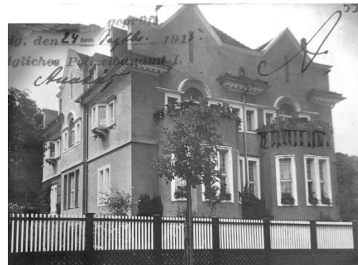
il. 92. Willa w stylu o wyraźnych wpływach architektury angielskiej, ul. Batorego 18, 1911 r. (fot. 1915r.)
