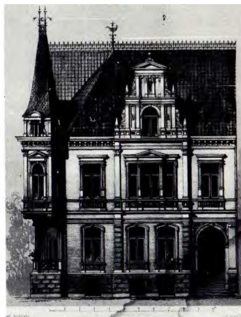
582 Hannover, Wohnhaus Ecke Königstraße/Am neuen Haus, Arch. F. Geb, 1876 (Zs. d. Arch. u. Ing.-Ver eins Hannover 1877, Bl. 717)
