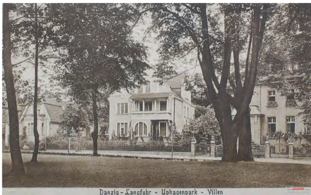
il. 70. Widok na willę przy ul. Uphagena, zlokalizowane na przeciwko terenów rekreacyjnych - nr. 19,21, i 23 (fot. 1914 r.)
