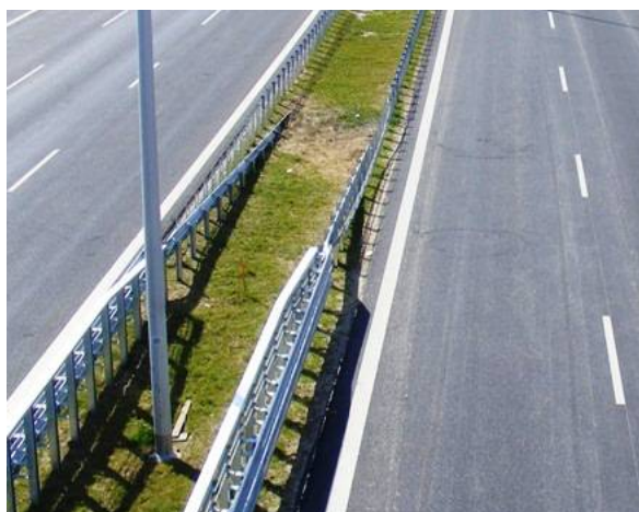
Fot. 1. Odcinki przejściowe barier ochronnych na Obwodnicy Południowej Warszawy [9]
