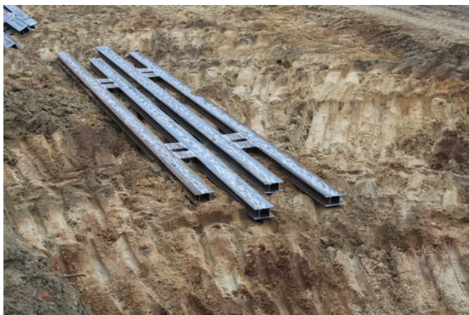
Rys. 5. Budowa Nowego Centrum Sopotu. Kleszcze górnego poziomu
