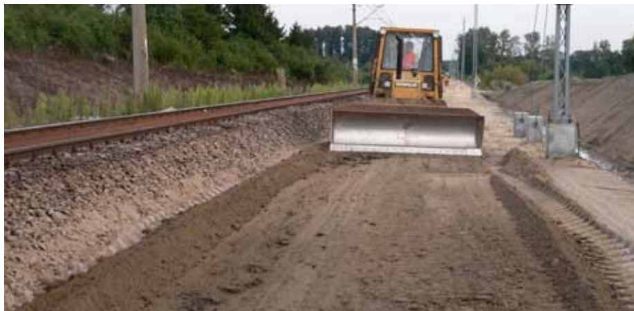
11. Profilowanie wykonanej warstwy podłoża
