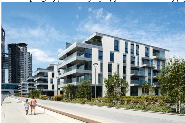
Autor: Nate Cook 9 | Zlicowanie stolarki okiennej z płaszczyzną ściany i ostra biel okładziny podkreślają ekspresję nielicznych trójkątnych balkonów bocznych elewacji
