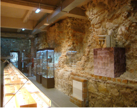
Ryc. 2 Eksponowany we wnętrzu mur przyziemia skrzydła północnego. Widoczne wnęki lunet i żelbetowy strop (2018, fot. autora)
