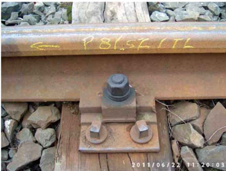
4. Przykład fotografii szczegółowej – oznaczenia: strzałka kierunek jazdy, P8 – 8 podkład, SZ- strona zewnętrzna toru, TL – tok lewy
