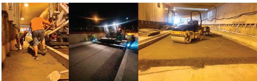
Fot. 2. Układanie betonu jamistego w tunelu na węźle „MPL Okęcie”
