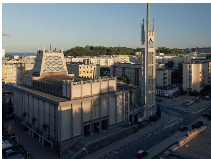
Rys. 1. Kościół pw. Najświętszego Serca Pana Jezusa w Gdyni, stan obecny
