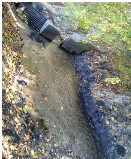
Rys. 3.7. Krata: a) widok z góry, b) dopływ potoku Swelina do piaskownika przez kratę (fot. Marzena Stosik)
