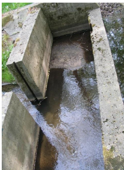
Rys. 3.8. Piaskownik (fot. Marzena Stosik)
