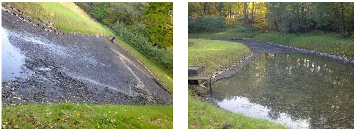
Rys. 3.9. Zbiornik sedymentacyjno-retencyjny na potoku Swelina w trakcie przygotowania do usuwania osadów dennych (fot. Marzena Stosik)
