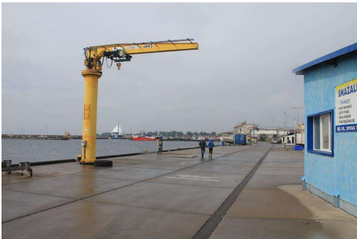
Ryc. 151 Nabrzeże Remontowe, Port, Hel (fot. M. Izydor)
